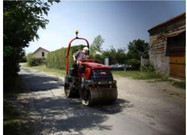
Le programme voirie de l'exercice 2014 a également compté des travaux d'arasement des accotements, route de Fouranges. Ce chantier était nécessaire car les écoulements de pluie ravaient le revêtement de la chaussée.
